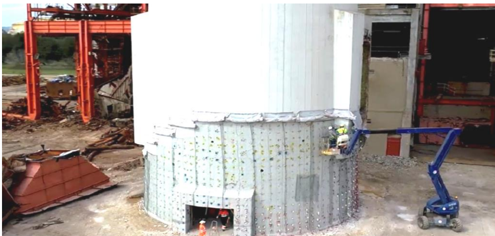
Figura 5.1 - Execução do plano de furação na cunha de implosão (AMBIGROUP, 2020)
