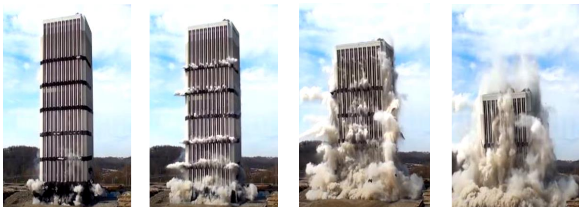
Figura 7.4 - Demolição controlada em planta por multi-implosão (CDI INC., 2018)
