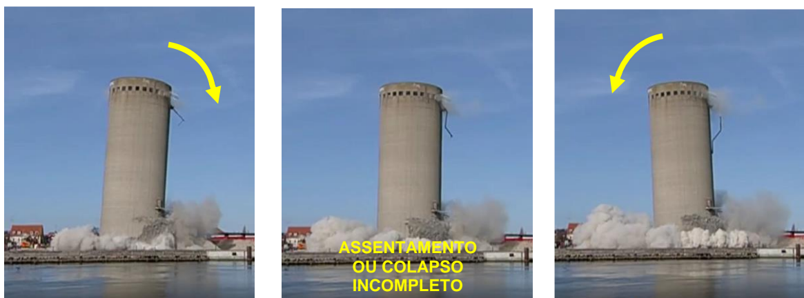
Figura 4.3 – Série de efeitos de desequilíbrio, assentamento e derrubamento (TV2 \Phi ST, 2018)
