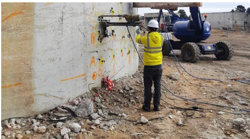
Figura 5.2 - Uso de equipamento de carotagem para a furação (Rodrigues, R. V. et al., 2019)
