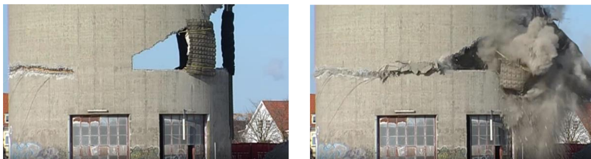
Figura 4.2 - Região pré-enfraquecida, antes e após a detonação (Vordingborg, TV2 \Phi ST, 2018)
