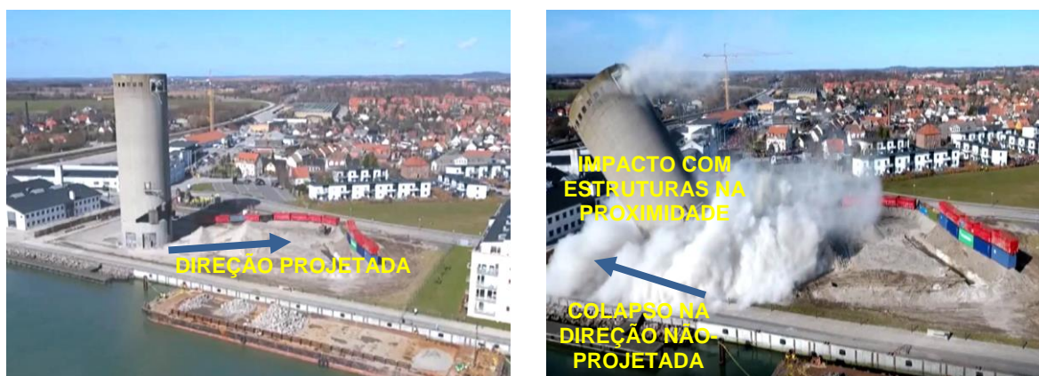
Figura 4.4 - Direção projetada vs direção real do derrubamento (TV2 \Phi ST, 2018)
