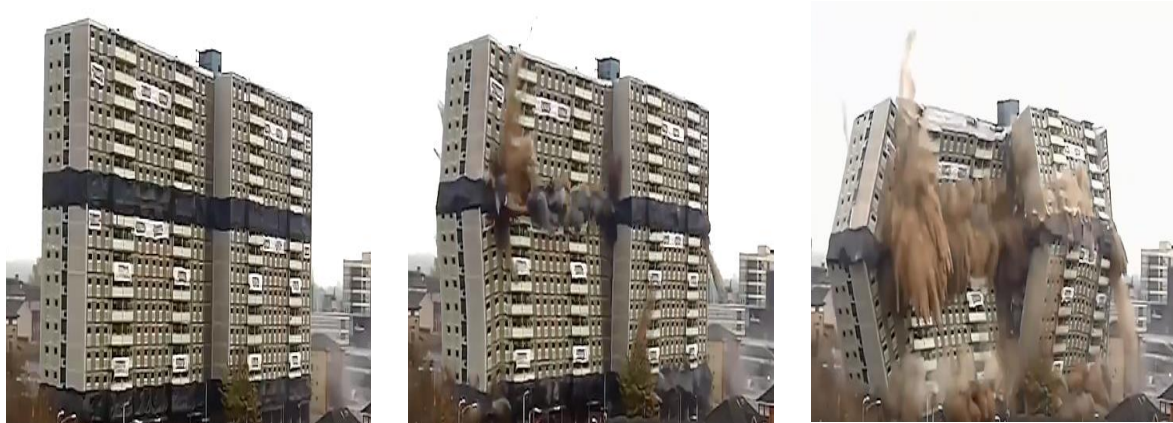
Figura 7.3 - Demolição controlada em planta por bi-implosão (MS BING.COM, 2019)
