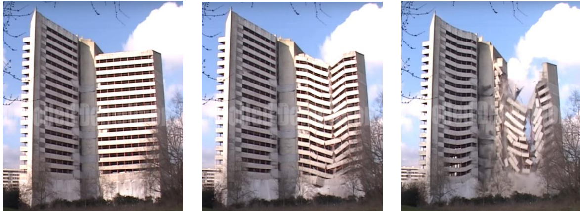
Figura 7.5 - Demolição controlada - sequência de colapso pós-implosão (MS BING.COM, 2005)
